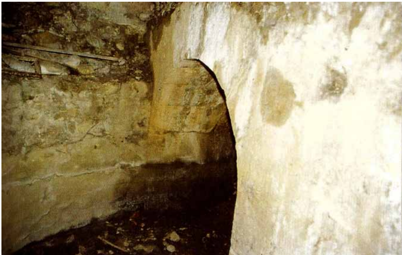
Canal du moulin des Mées. Passage en tunnel sous le boulevard des Tilleuls
