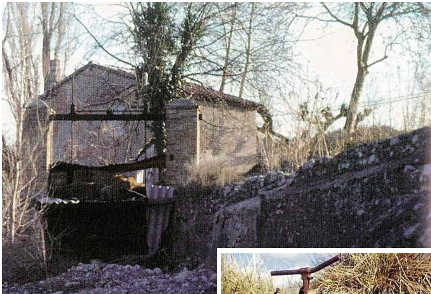
Prise sur la Bléone du canal du moulin des Mées. Etat vers 1980
