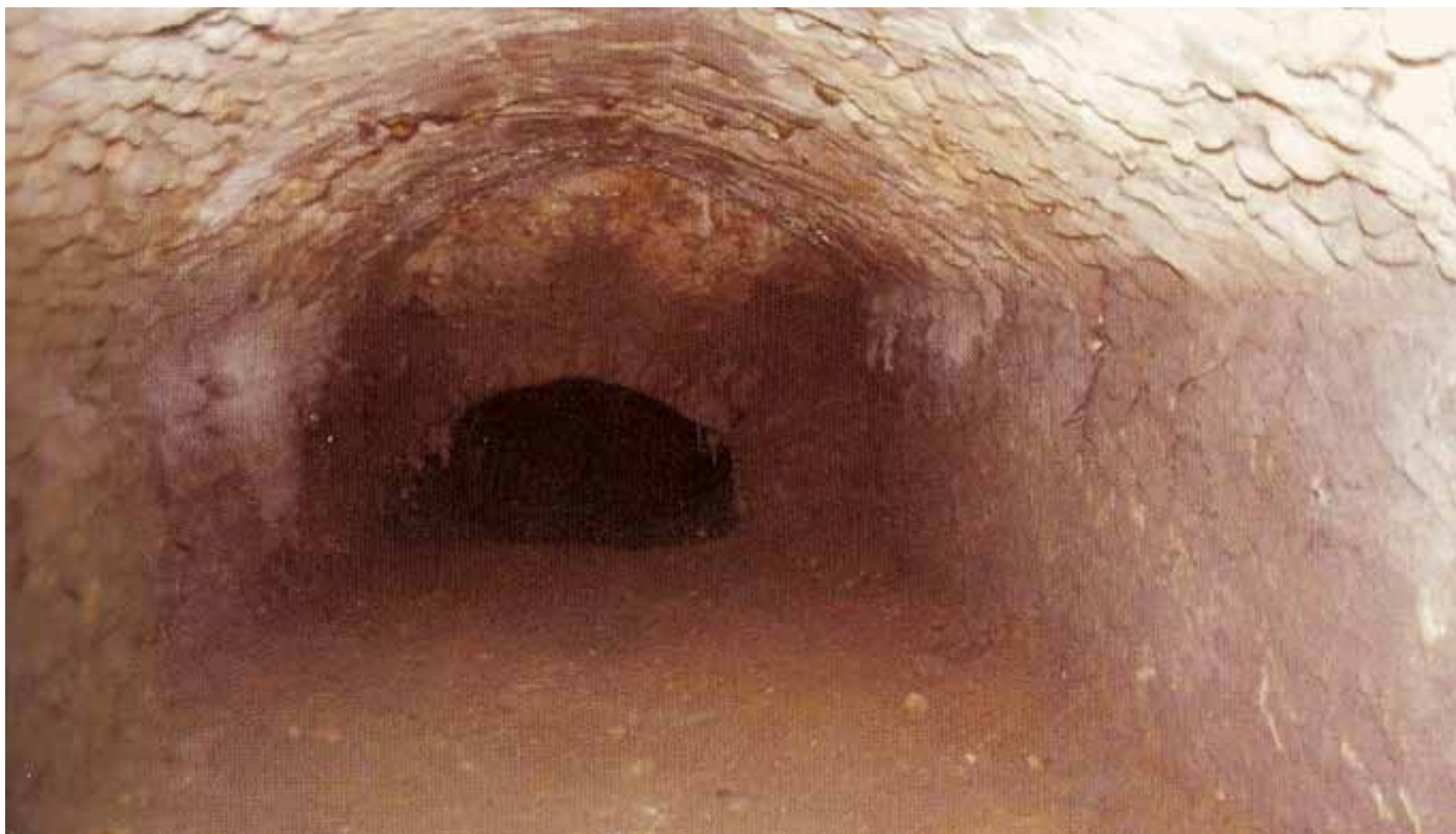
Canal du moulin des Mées. Passage en tunnel sous le boulevard de la République
